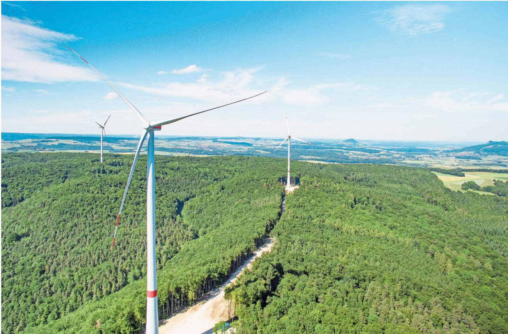
Zurzeit die grösste Windenergieanlage in der Region: die drei Anlagen Verenafohren nahe Schaffhausen.
