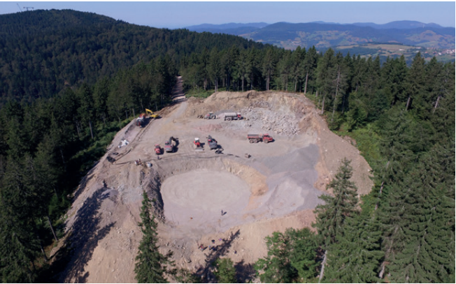
Baustelle Windrad Gersbach im Schwarzwald. Foto: Freie Landschaft Schweiz
